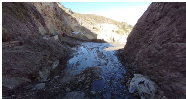
vista desde aguas arriba hacia trucha, se observa encajamiento de cauce y salida tipo vertedero
